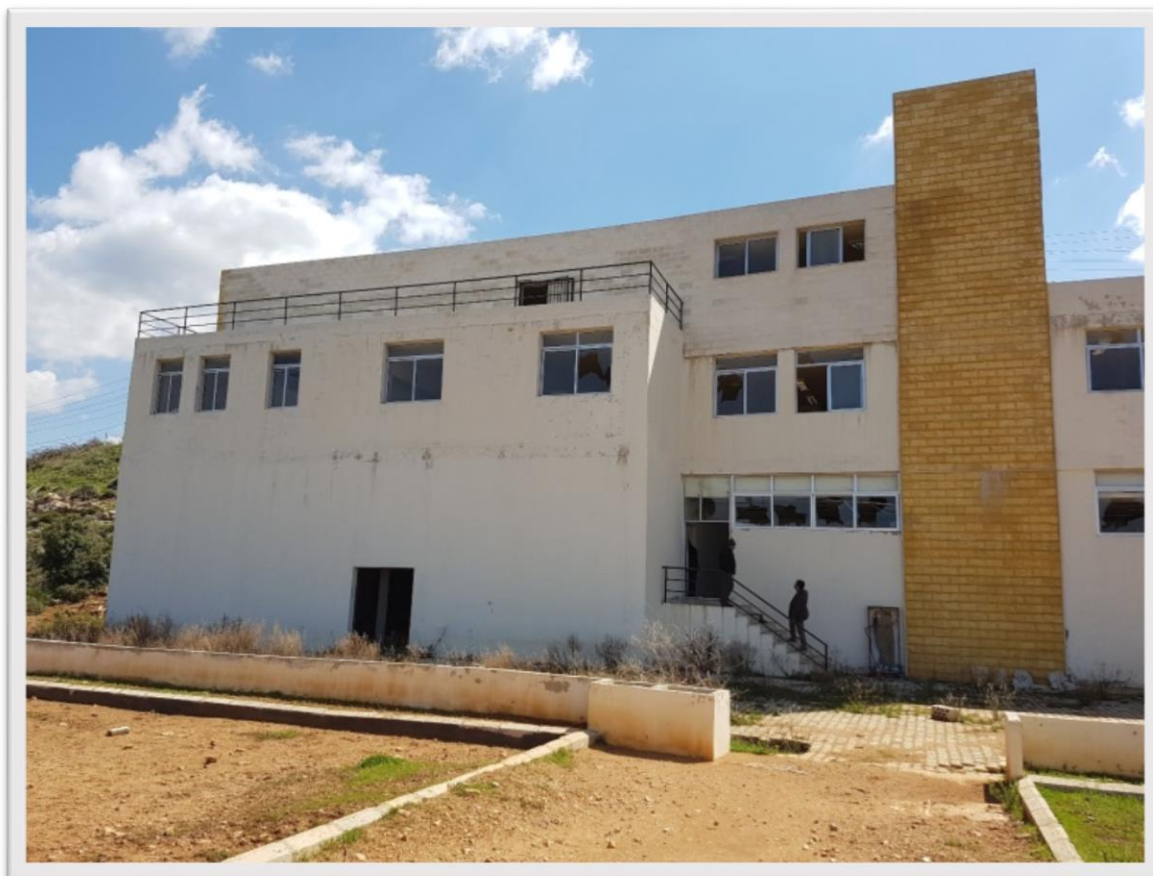
Face avant du Bâtiment
